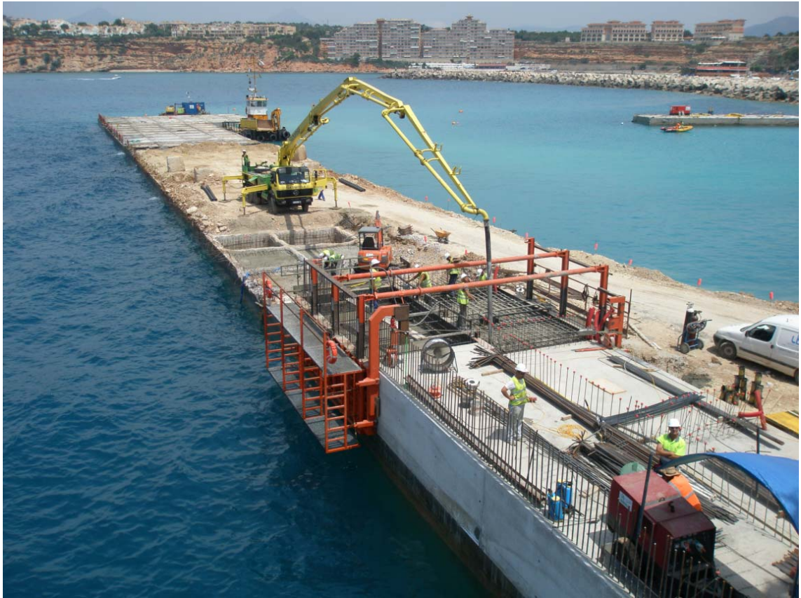
Fotos del encofrado del espaldón
