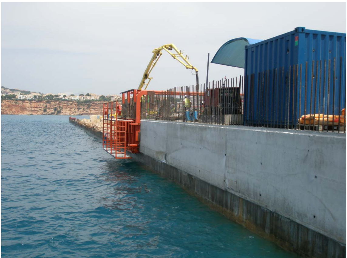
Fotos del encofrado del espaldón
